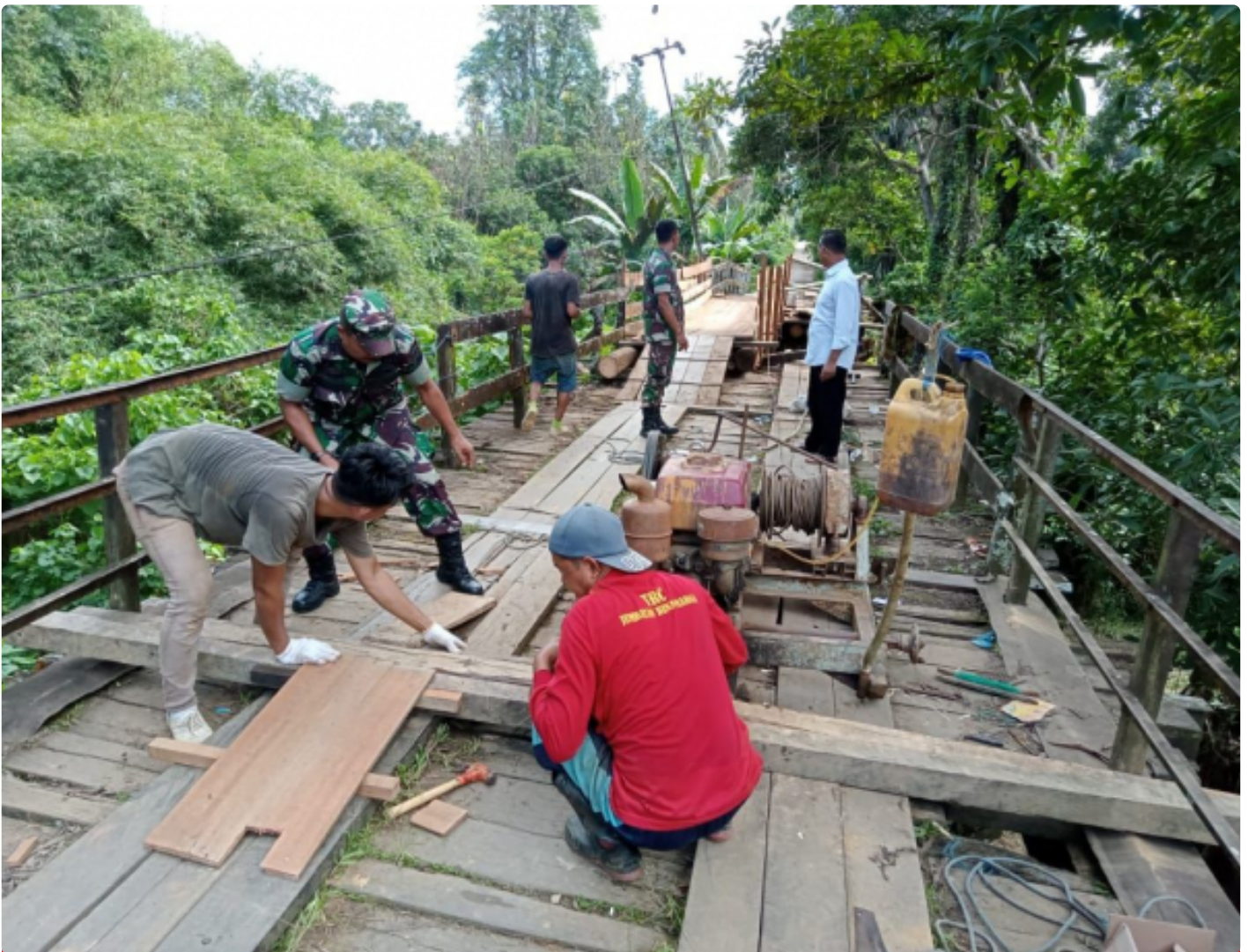
Babinsa Koramil 1008-01/Muara Uya Ikut Gotong Royong Perbaiki Jembatan
